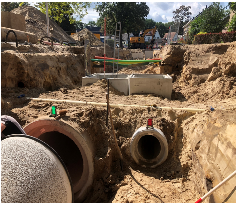
Ombouw riolering en afkoppelen verhard oppervlak Krugerstraat door aanbrengen infiltratieriolen
