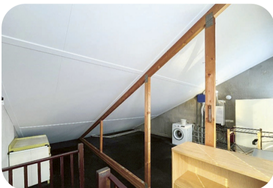
Zolder na isoleren
