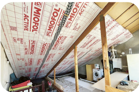
Zolder tijdens isoleren
