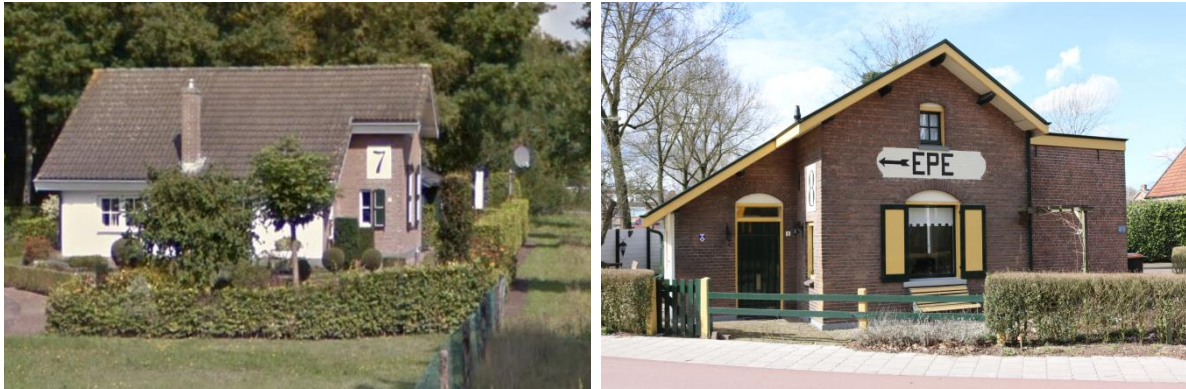
Figuur 64. Wachtpost 7 (links) aan de Krakerweg en wachtpost 8 aan de Heerderweg in Epe zijn de enige nog bestaande wachthuizen. Wachtpost 8 heeft de status van gemeentelijk monument. Foto's: Google Maps (l) en Wikimedia Commons (r).
