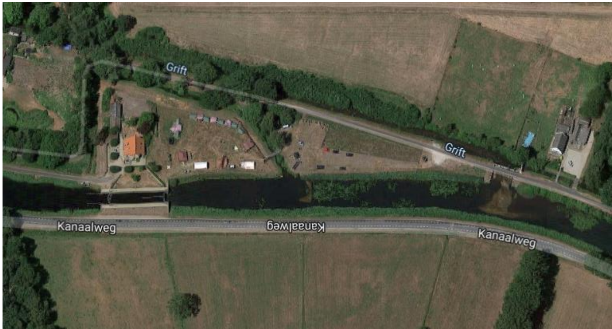
Figuur 66. De Vaassense sluis met sluiswachterswoning, gelegen op een eiland tussen de Grift (boven) en het Grifkanaal (noorden rechts). Bron: Google Maps.
